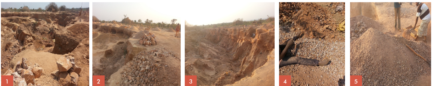
Fig. 1, 2, 3 : Vue d'ensemble de la carrière et Poste 1, concasseurs des roches en moellons / Career overview and Station 1: stump crushing
