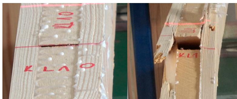
Figure 8. Failure in beam-type KL.
