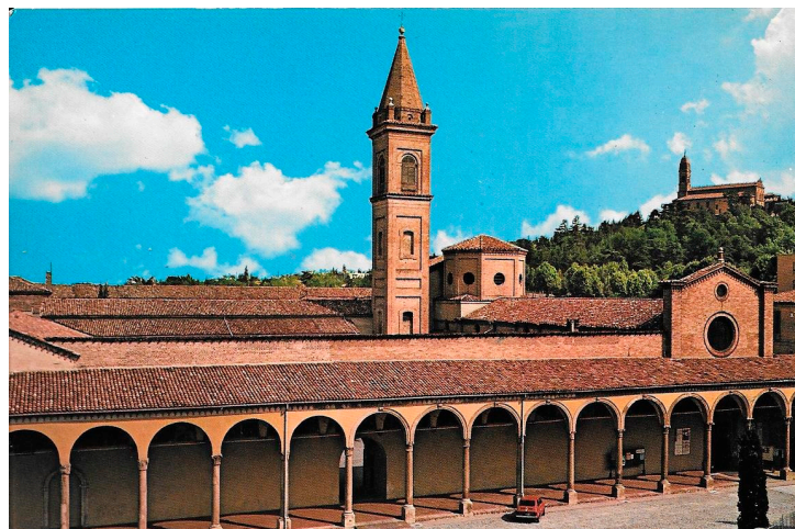
Figure 23. Tie rods in the portico of Chiesa di Santa Maria Annunziata, Bologna, Italy.
