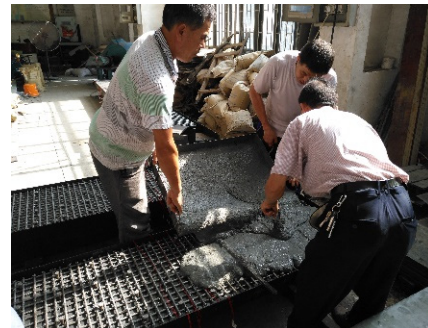
(d) Casting of UHPFRC
