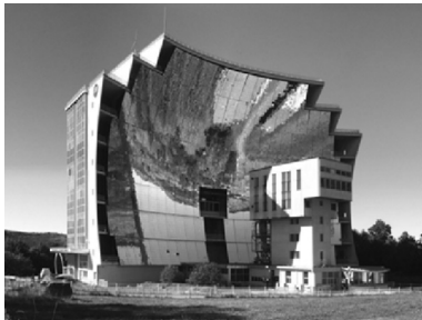
Fig. 2. The 1 MW (world's largest) solar furnace of the CNRS Font Romeu Odeillo, France. CNRS, Centre National de la Recherche Scientifique.
