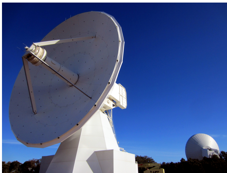
Figure 1. Yebes Red Atlántica de Estaciones Geodinámicas y Espaciales (RAEGE) VGOS (Very Long Baseline Interferometry (VLBI) Global Observing System (VGOS)) 13.2 meter radio telescope.
